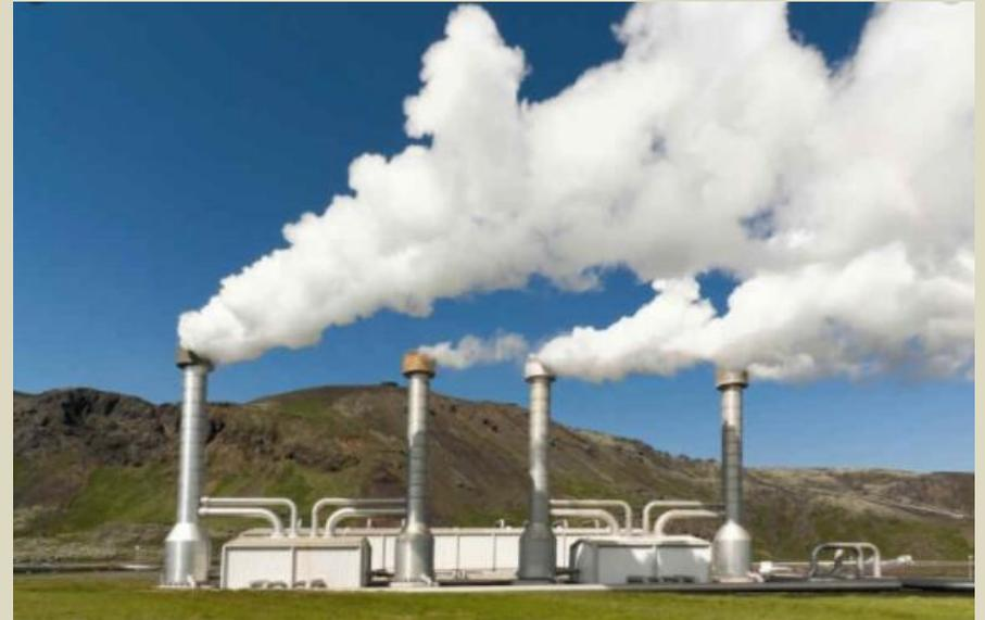
**ENERGÍA GEOTÉRMICA.** SE OBTIENE APROVECHANDO EL CALOR DEL INTERIOR DE LA **TIERRA** (DONDE LA PRESIÓN Y LA **TEMPERATURA** SON ELEVADAS), PARA HACER HERVIR AGUA Y POTENCIAR MEDIANTE EL VAPOR LAS TURBINAS DE UN GENERADOR, O RECONducIR EL CALOR DEL GAS PARA DARLE OTROS USOS. TIENE LA DESVENTAJA DE ESTAR RESTRINGIDA A ZONAS VOLCÁNICAS. ADEMÁS, LOS COSTOS PARA LA EXPLOTACIÓN Y OBTENCIÓN DE ESTE TIPO DE ENERGÍA SON ELEVADOS.
