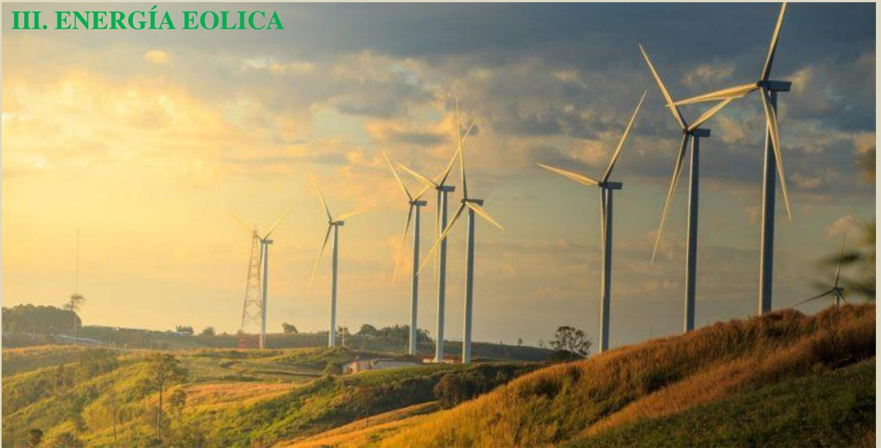
**ENERGÍA EOLICA.** ES LA ENERGÍA QUE SE GENERA APROVECHANDO EL VIENTO QUE PASA TRAVÉS DE AEROGENERADORES, QUE TRANSFORMAN EL **MOVIMIENTO** DEL AIRE EN **ENERGÍA ELÉCTRICA**. CUANDO EL AIRE PASA CON FUERZA SOBRE LAS ASPAS DE MOLINOS ESPECIALES, ESTOS SE ACTIVAN HACIENDO GIRAR ENGRANAJES Y UNA DINAMO, Y GENERANDO ASÍ **ENERGÍA ELÉCTRICA**.
